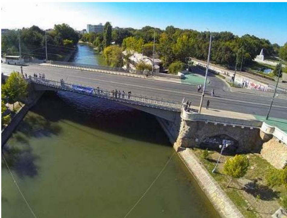
Timisoara – Podul Traian cu vedere spre Parcul Central (vedere din drona – sursa foto: eyeinthesky.ro )
