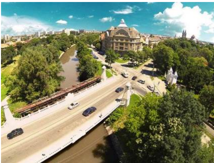
Podul Decebal - „podul de la Baile Neptun”. Dateaza din 1909 si era, la acea vreme, podul pe grinzi de beton armat cu cea mai mare deschidere din Europa. Proiectul a fost distins cu Diploma de onoare la Expozitia Internationala de la Paris din 1910.. Inaintea regularizarii noului canal, in apropierea podului a existat Canalul Plutaritului , care era traversat de un pod de lemn. (Sursa foto: eyeinthesky.ro )
