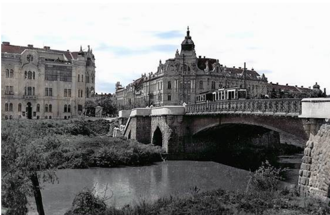
Timisoara – Noul pod "Traian" construit dupa demolarea si mutarea podului metalic (imagine de arhiva)
