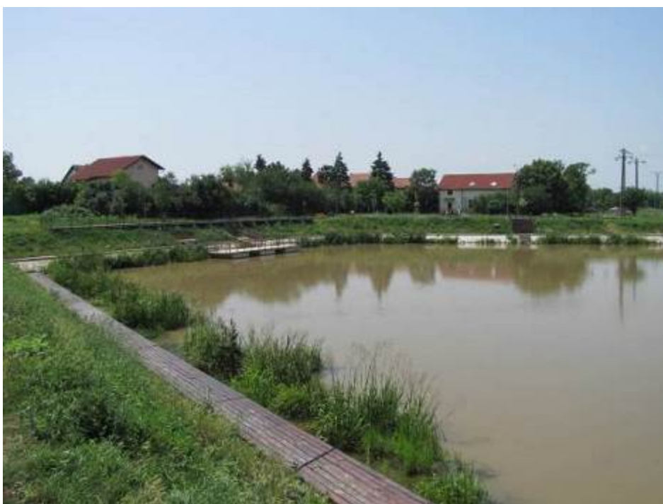
Modernizarea Canalului Bega – Bucla de întoarcere a vapoarelor în apropierea Podului Modos. Foto: C. Liciu 2016
