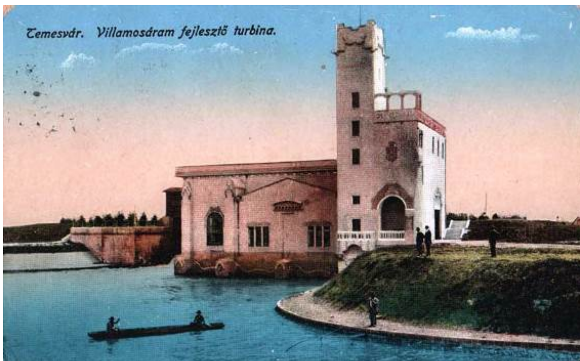
Anul 1911 – "Uzina Hidroelectrică" (imagine de arhivă)
