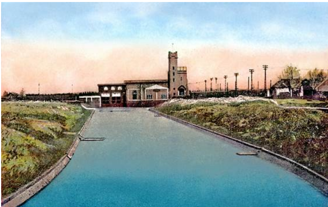
Anul 1911 – "Uzina Hidroelectrică" (imagine de arhivă)
