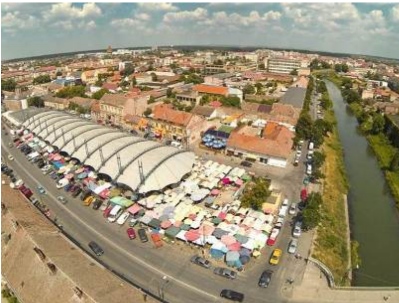
TIMISOARA – Piata Badea Cartan (mai este numita si Piata de Fan ), in dreapta Canalul Bega cu vedere spre Podul Mihai Viteazul si Uzina Hidroelectrică . Sursa foto: eyeinthesky.ro
