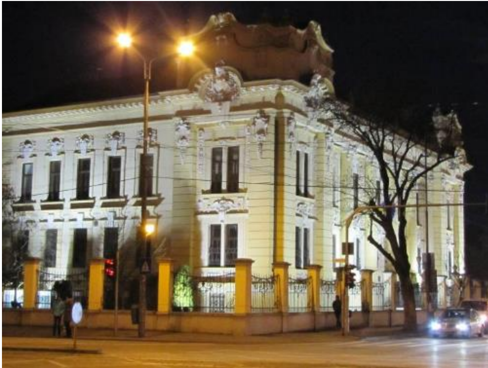
Banca Nationala - Aut. de constr. 05.11.1903, terminată (aut. de funcționare) 25.10.1904. A fost prima construcție realizată imediat după demolarea fortificațiilor bastionare din sec. al XVIII-lea în partea de est a Cartierului Cetate.
