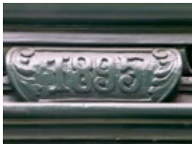
Anul construcției pe poarta imobilului.
