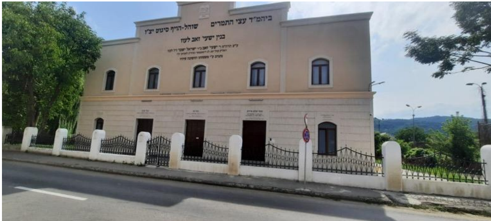
Sinagoga mare a hasidimilor Satmar, reconstruită recent la Sighet
