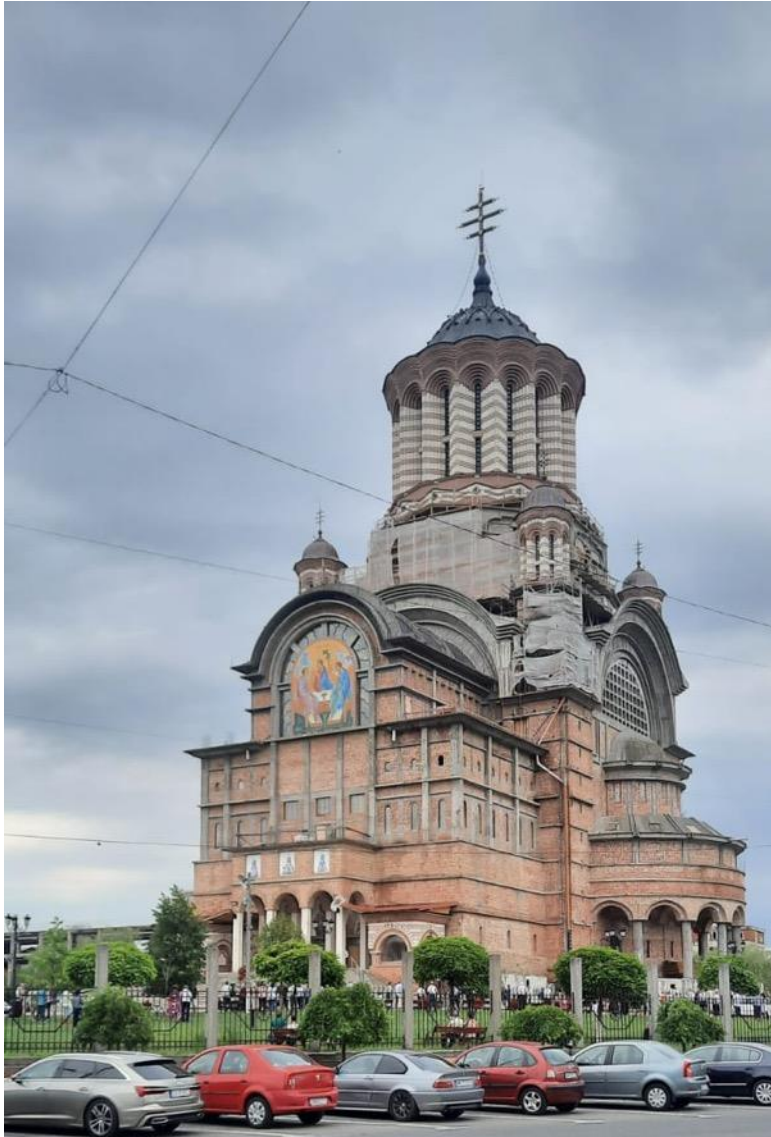
Catedrala ortodoxă în construcție la Baia Mare
