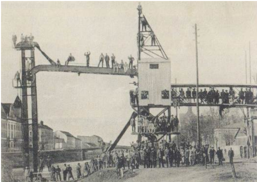
Moara cu aburi Prohaska 1912. Elevator pentru descărcat cereale aduse pe canalul Bega.
