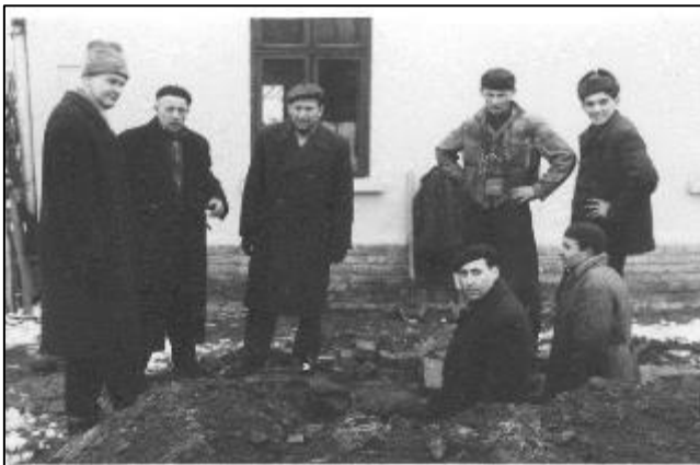
Tomi în șanțul cu cabluri.
