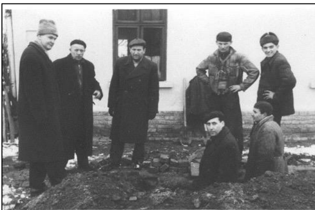
Tomi în șanțul cu cabluri.
